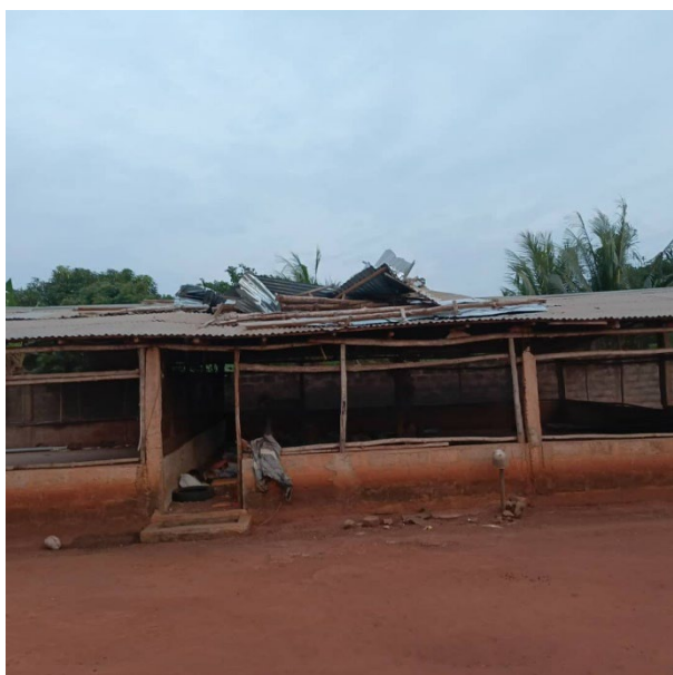
Photo 1 : Vue poulailler d'un jeune ayant repris une ferme (toit décoiffé par un vent)
